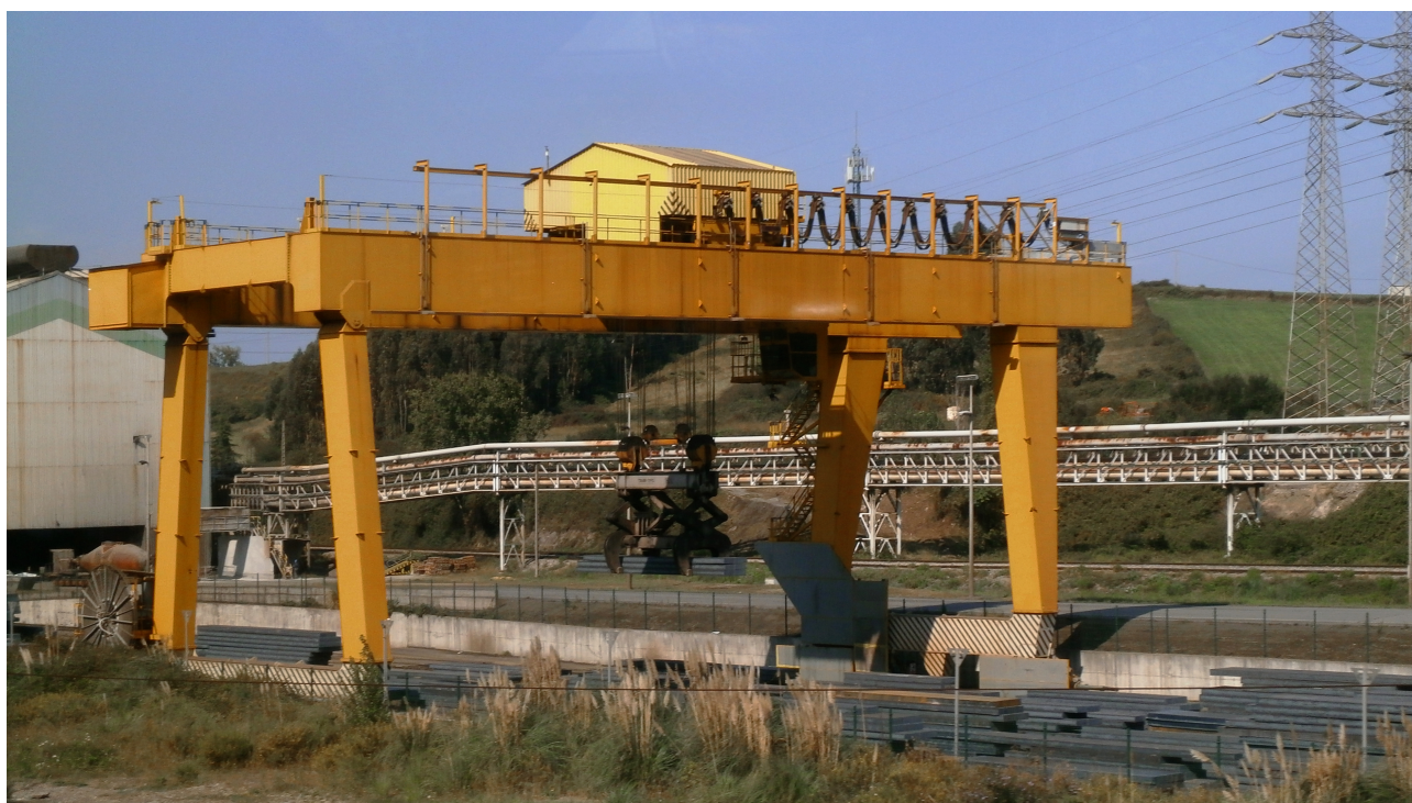
Figura 2.1: Grúa transportando desbastes. Autor: Borvan53, vía Wikimedia Commons, bajo licencia CC BY-SA 4.0 ( link ).
