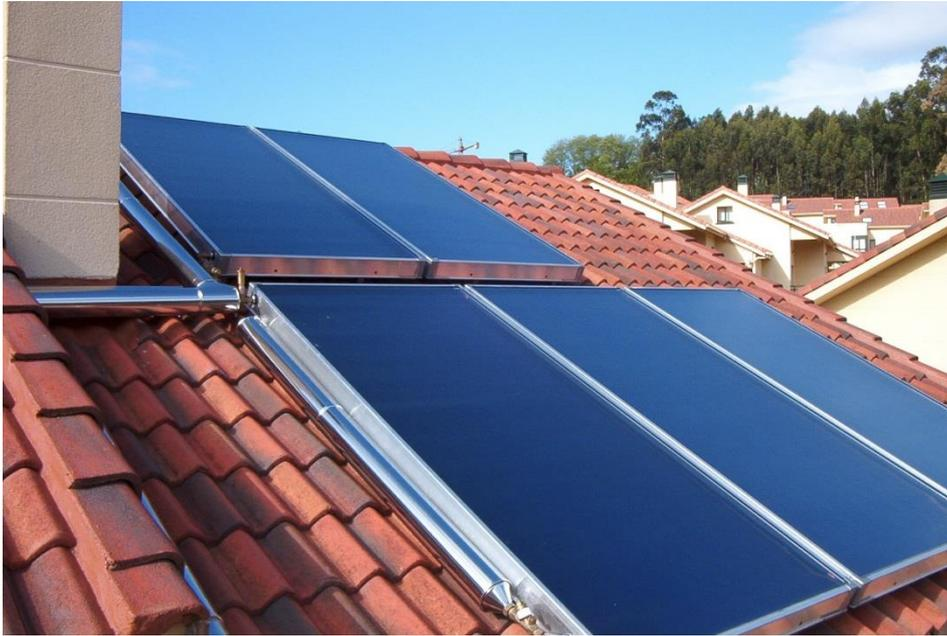
Figura 1.1. Sistema solar térmico integrado en la cubierta de una vivienda.
