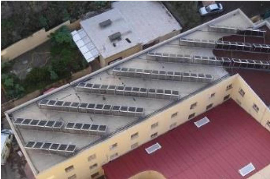
Figura 3.6. Campo de captación solar térmico situado en la cubierta de un edificio.
